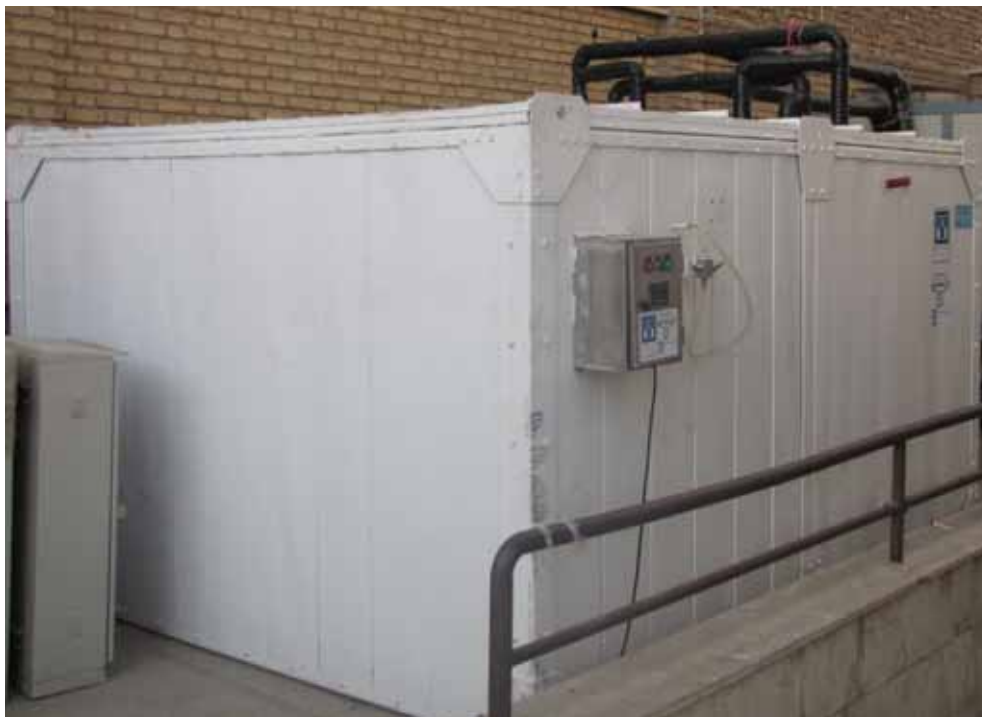
مخزن ذخیره‌سازی سرما مورد استفاده در سیستم ذخیره‌سازی نمونه
