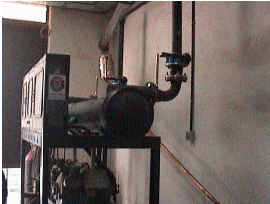
چیلر تراکمی دو کمپرسور مجهز به unloader مورد استفاده در سیستم ذخیره‌ساز نمونه
