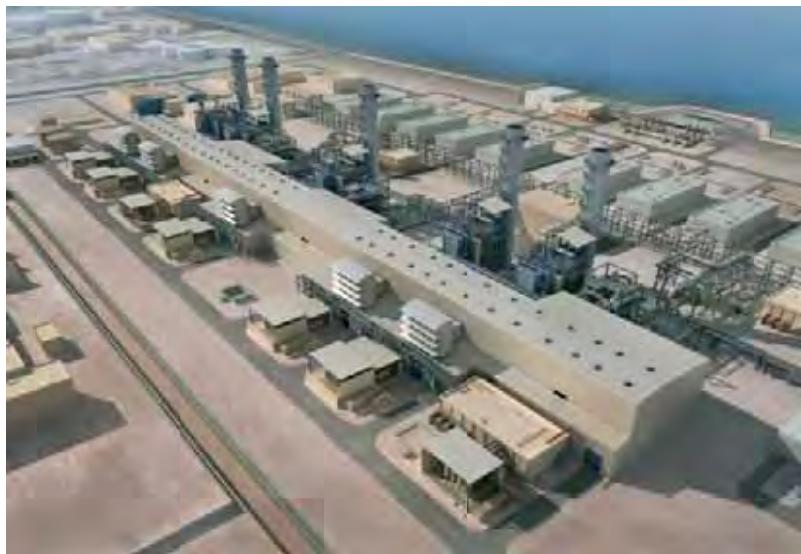
در این طرح، واحدهای گازی و سیکل ترکیبی احداث شده و در دست احداث حاشیه خلیج فارس مورد بررسی قرار گرفت و واحدهای مستعد برای به کارگیری این فناوری مشخص شد. در این طرح با استفاده از اطلاعات آب و هوایی محل سایت نیروگاه نمونه در طول سال، ظرفیت بهینه چیلر جذبی برای خنک کاری هوای ورودی به توربین گاز با
