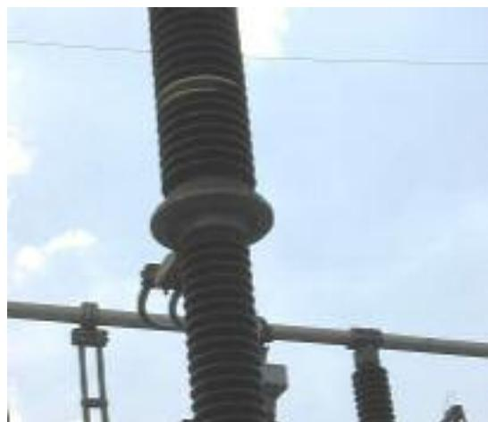
در تحقیقات انجام شده، ترمیم انواع مقره در آزمایشگاه و در محل پست انجام شد که در حال حاضر نمونه ترمیم شده در پست، تحت شرایط بهره‌برداری قرار دارد. همچنین به منظور ارزیابی دقیق‌تر روش انتخابی، آزمونهای عایقی استاندارد بر روی مقره‌های ترمیم شده انجام و با نتایج آزمونهای مقره آسیب‌دیده و سالم از نوع مشابه، مقایسه گردید. مقره ترمیم شده، آزمونها را با موفقیت پشت سر گذاشته و مقایسه نتایج، صحت روش بکاررفته را مورد تائید قرار داد.
