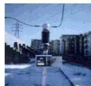
ترانسفورماتور جریان توری (OCT)
