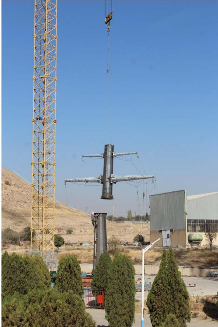
شکل ۴. تصویر دکل AA-T در حال مونتاژ قائم
