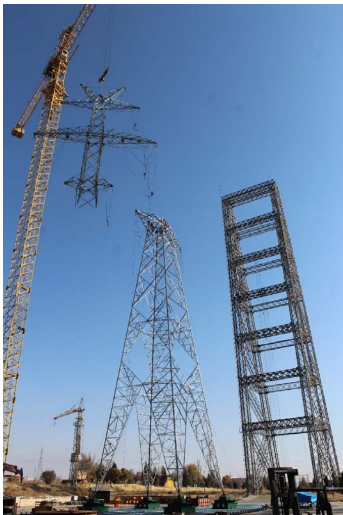
شکل ۷. تصویر دکل BM4S03 در حال مونتاژ قائم
