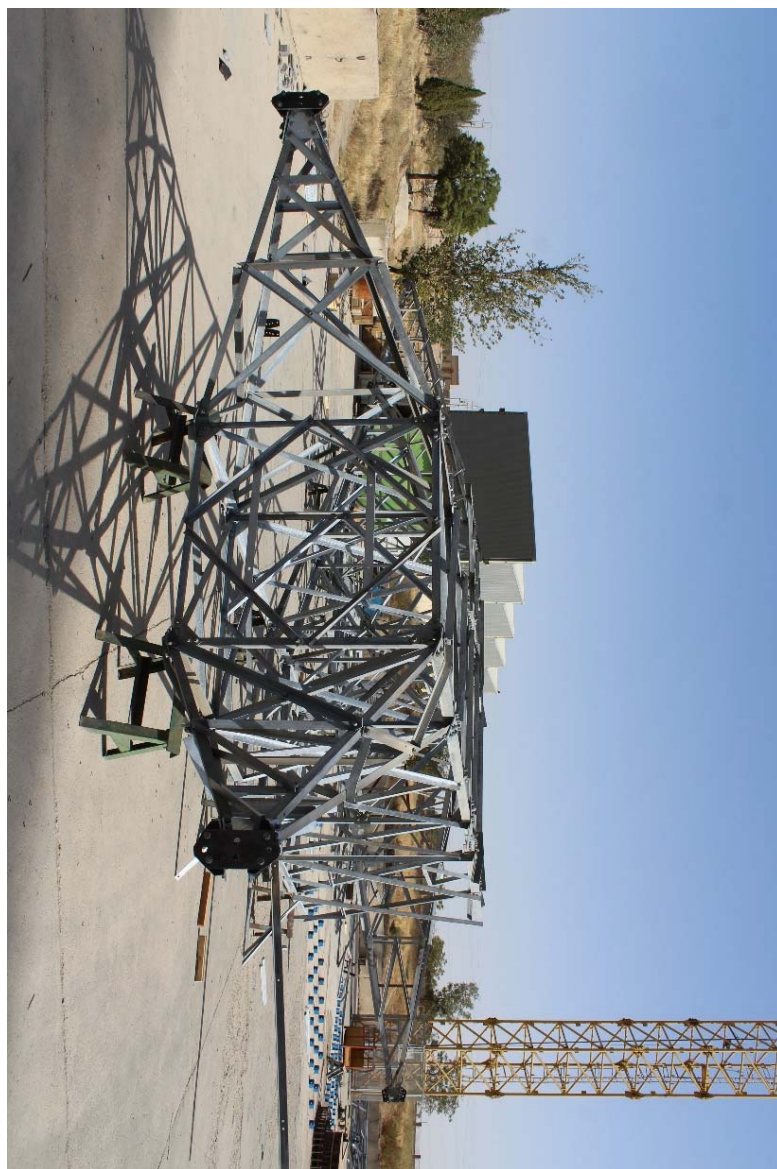
شکل ۱. تصویر دکل M4T30 در حال مونتاژ افقی
